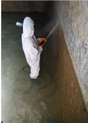
รูปที่ 2-47 ล้างถังเก็บน้ำ ครั้งที่ 1 เมื่อวันที่ 9-10 มกราคม 2567 ครั้งที่ 2 เมื่อ 23-24 กันยายน 2567
