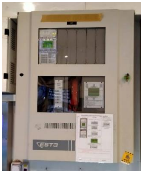
แผงควบคุม (Fire Alarm Control Panel : FCP) Fire Alarm Pull Station
