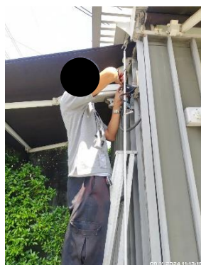
รูปที่ 2-36 ตรวจสอบ ระบบ CCTV รอบโครงการ ทำความสะอาด,ปรับความชัด,ปรับมุมกล้อง
