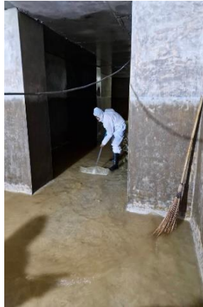
รูปที่ 2-47 ล้างถังเก็บน้ำ ครั้งที่ 1 เมื่อวันที่ 9-10 มกราคม 2567 ครั้งที่ 2 เมื่อ 23-24 กันยายน 2567
