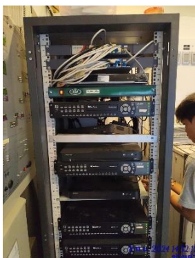
รูปที่ 2-36 ตรวจสอบ ระบบ CCTV รอบโครงการ ทำความสะอาด,ปรับความชัด,ปรับมุมกล้อง
