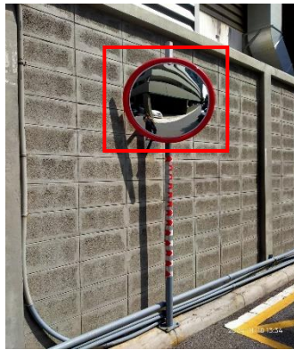
รูปที่ 2-14 การติดตั้งกระจกโค้งจราจร
