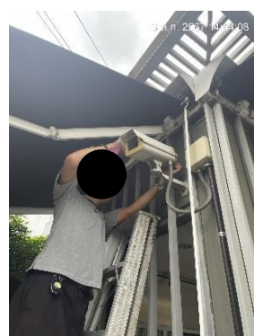
รูปที่ 2-36 ตรวจสอบ ระบบ CCTV รอบโครงการ ทำความสะอาด,ปรับความชัด,ปรับมุมกล้อง
